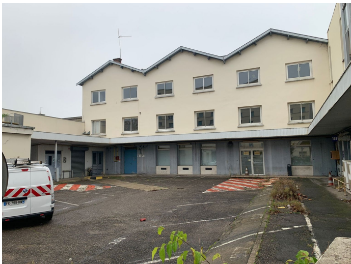
Accès au sud depuis rue du professeur Beauvisage
